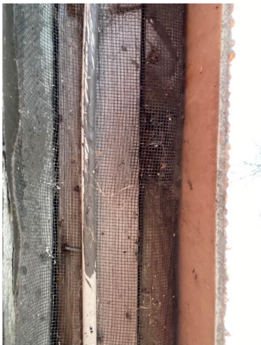
Foto tatt under fasadesystem som viser bindingsverk, isolasjon under musebånd m/ Steniplate ytterst
