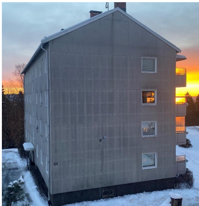
Foto viser en gavlfasade der bakenforliggende bindingsverk og kuldebroer kommer til syne
