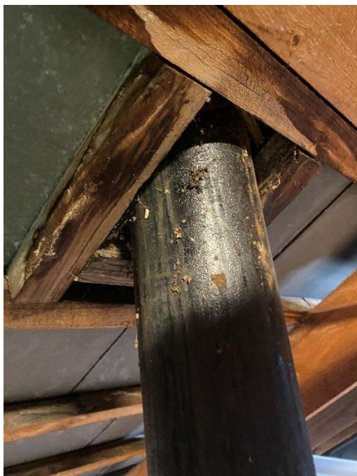
Foto viser fuktskader ved gjennomføringer
