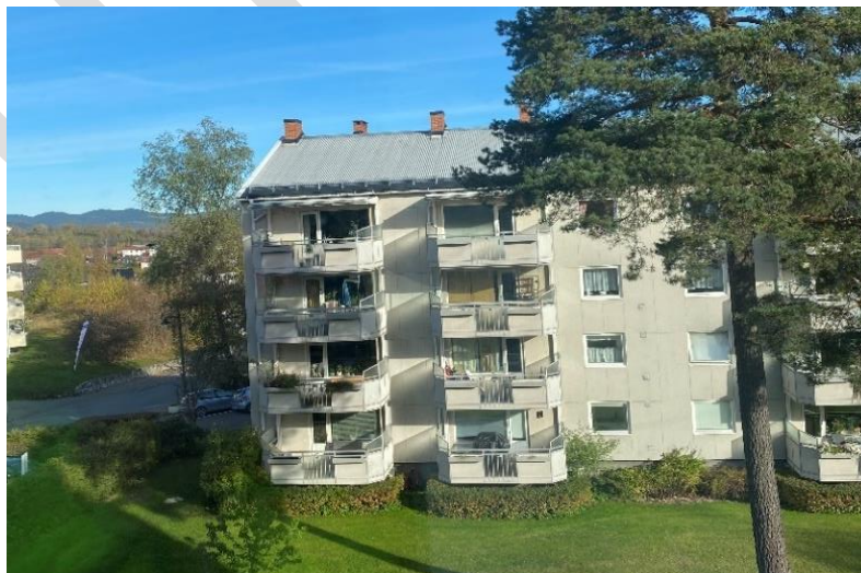
Foto viser en av blokkene med tak bestående takteking av forsinkede stålplater
